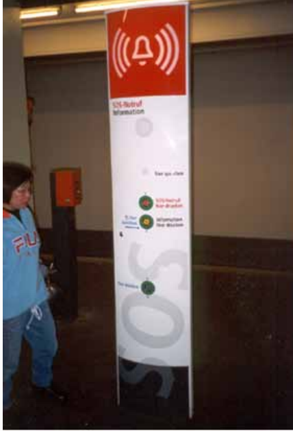
شكل ١١٣: تجهيز منصة الإركاب بوسيلة اتصال للطوارئ
