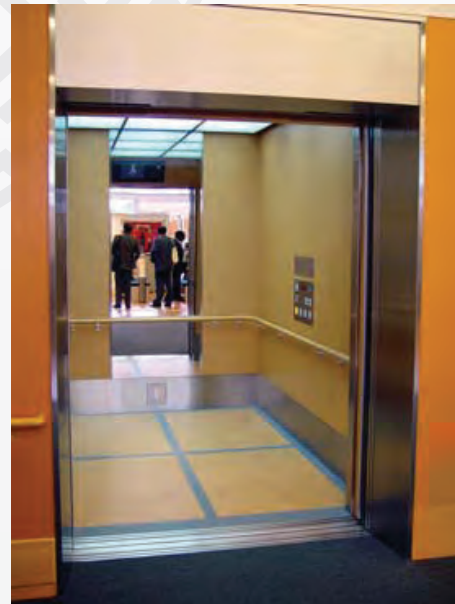
شكل ١٤٧: مصعد يوضح أضرار الاتصال الداخلية المنخفضة والكبيرة، والتعريف اللوني للطابق.
