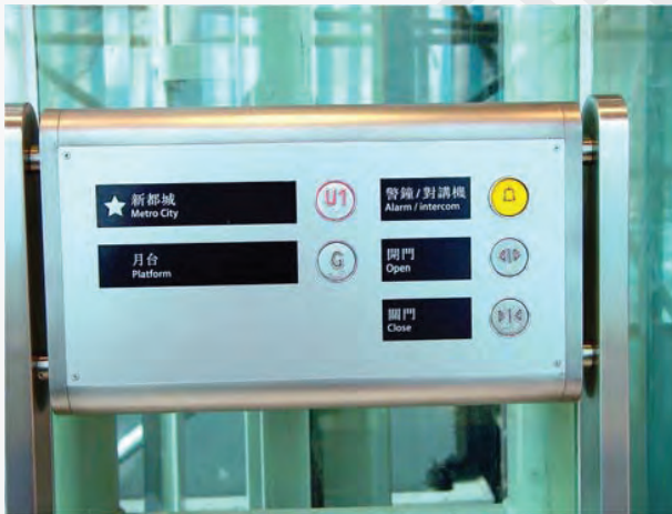
شكل ١٤٨: مثال على سطح التحكم في المصعد يمتاز بالتباين اللوني، والنص ثنائي اللغة يمكن قراءته باللمس والأزرار والرموز.
