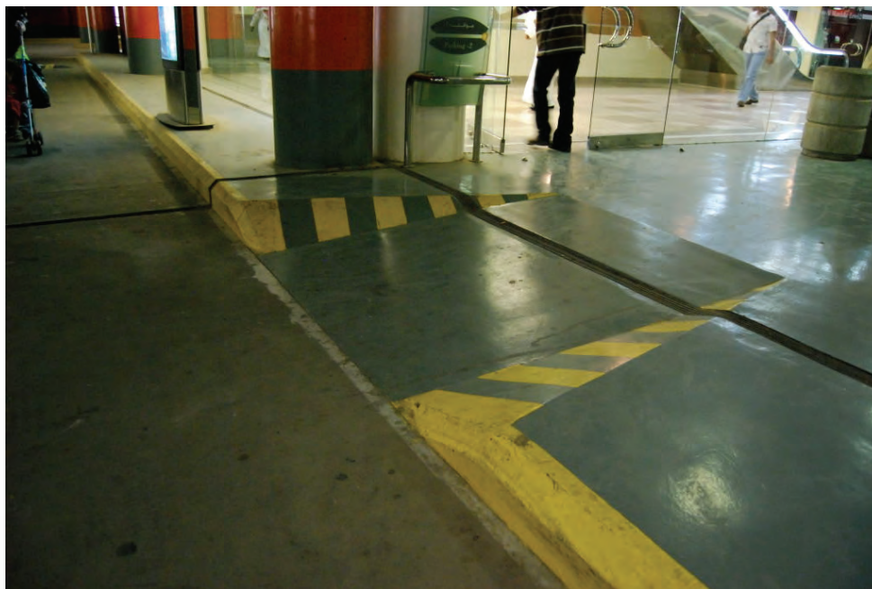
شكل ١٣٤: مثال على المنحدر، لاحظ أن وصلة الامتداد تجعل الوصول من خلال هذا المنحدر صعباً.
